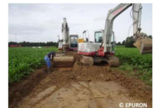
Création d’un chemin au coeur d’une parcelle : phase travaux
